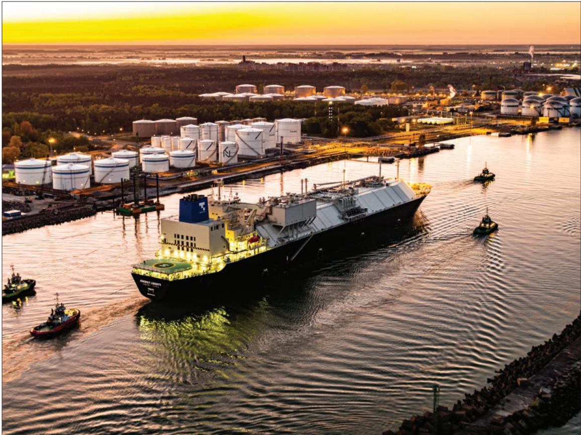
LNG carrier Energy Liberty is moored at Klaipėda LNG terminal for LNG reloading operation. Image by: Andrius Pelakauskas/ Klaipėda Nafta. March 23, 2020
